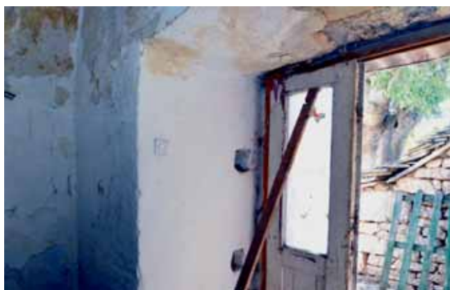
Rupe za grede drugog ulaza u crkvu u zidu
