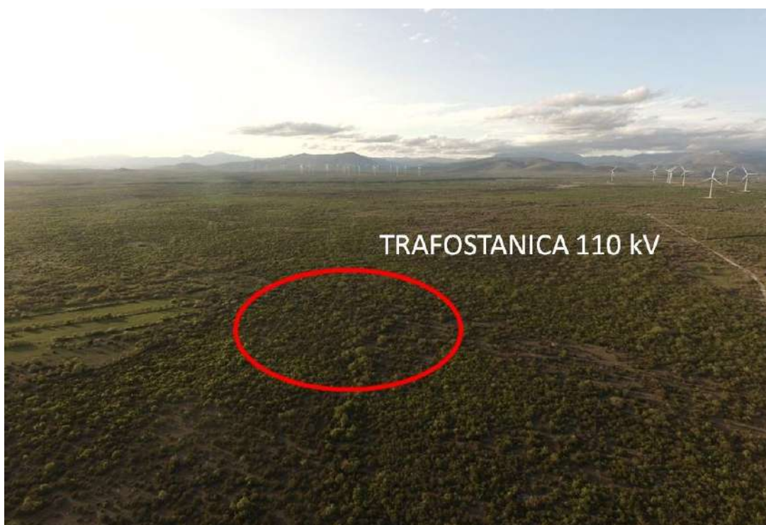
Fotografija C-8: Pogled iz zraka na prostor izgradnje trafostanice 110 kV
