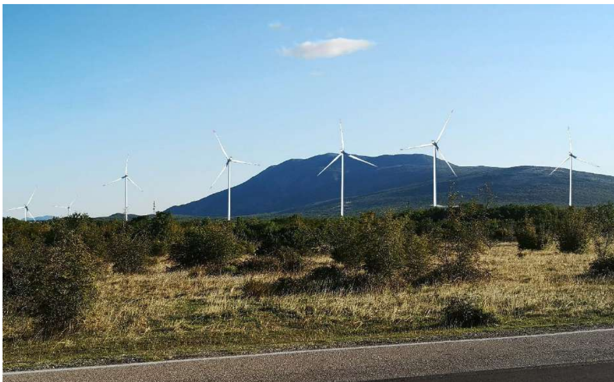
Fotografija D-3: Vizura V3 - Pogled s prometnice 6056 -Oklaj-Knin na lokaciju zahvata
